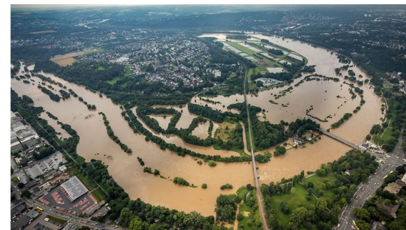
Hochwasserkatastrophe 2021: Die Flut hat schwere Schäden auch an Kulturdenkmälern verursacht.
