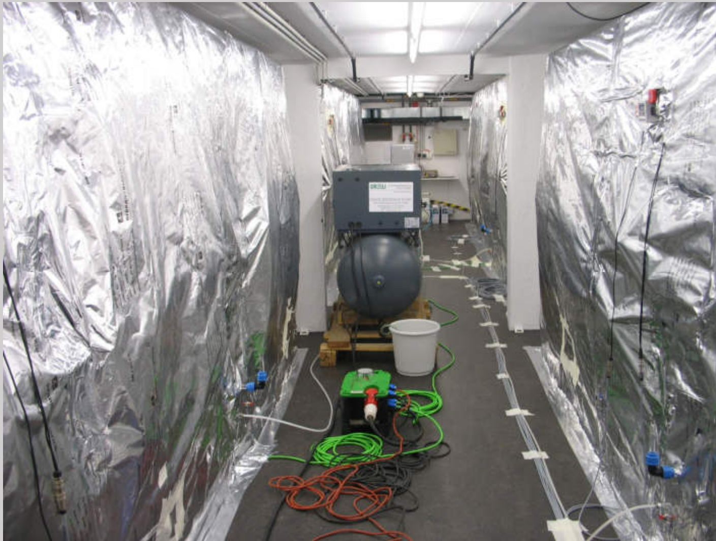
anoxische Totalbehandlung eines Archivmagazins nach Brotkäferbefall
